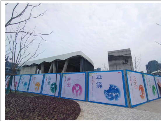
施工场地围挡
