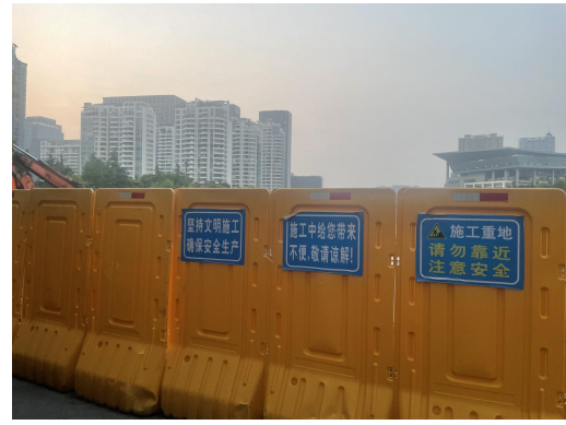
施工场地围挡
